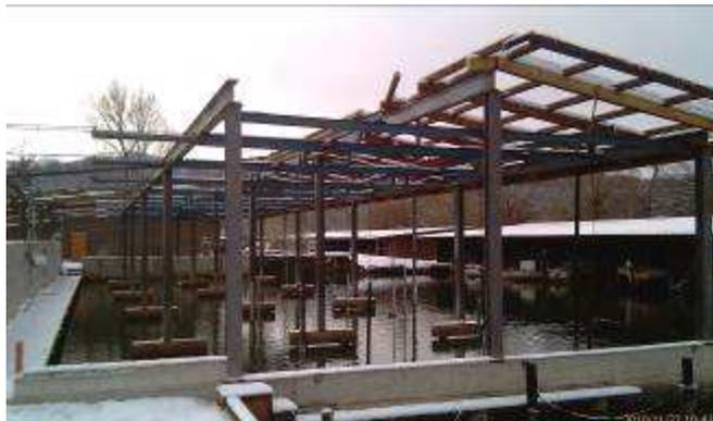
In einem ersten Schritt erfolgte der Rückbau des asbesthaltigen Daches, gefolgt vom Stahlgerüst, den Betonmauern sowie den Fundationspfählen. Die Wasserbaufirma entschloss sich diese Arbeiten nicht mithilfe eines Pontons, sondern mit einer verschiebbaren Plattform auszuführen.
