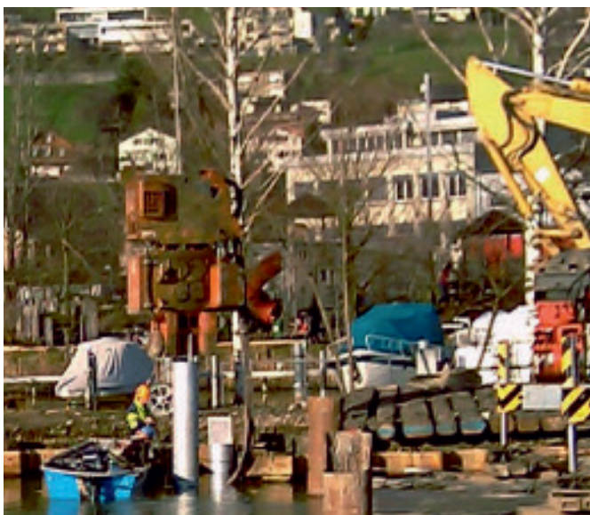
Pfählungen für neue Bootshalle
